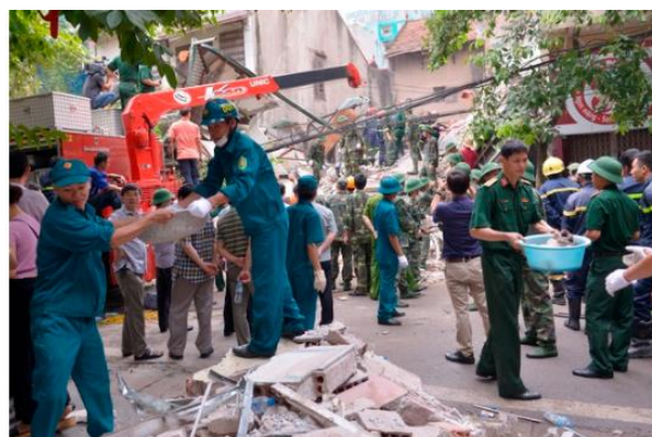
Các lực lượng vũ trang phối kết hợp hỗ trợ giải cứu nạn nhân mắc kẹt trong vụ sập nhà số 43 phố cửa Bắc quận Ba Đình
